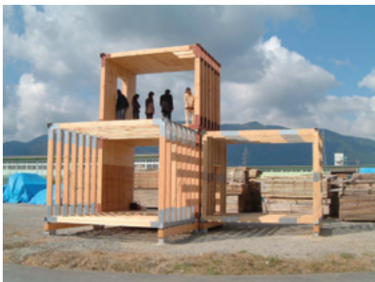
間伐材を用いた耐震型ユニット建築システムの実践 Development of sustainable timber-building system
