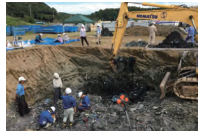
廃棄物処分場での現地調査の様子
