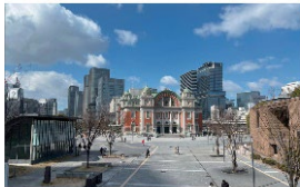
公会堂周辺は中之島景観軸の端線と公会堂の向きとのずれに導かれながら、またまたマンパルが一体の形式とした。景観軸や対峙しの位置の相違、交差、並行の対峙の連続性により、景観軸が、景観軸が持つ「都市景観の軸」の連続性、公会堂を際立たせている。
